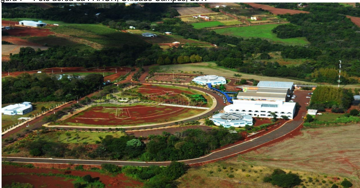
Figura 7 – Foto aérea da FAHOR, Unidade Campus, 2017
