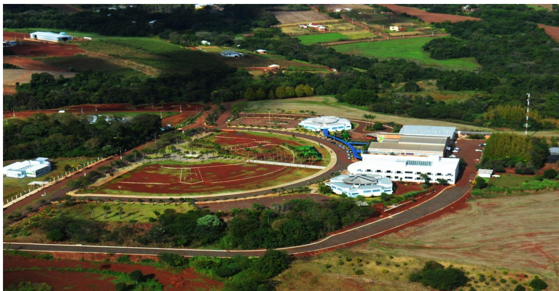
Figura 6 - Foto aérea da FAHOR, Unidade Campus, 2017
